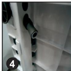
5. Collegare il nuovo raccordo di scarico al tubo di scarico dell'acqua.
