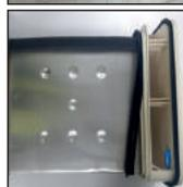
6. Plaats de condensator terug. Zorg ervoor dat u hem in de juiste richting plaatst (volgens de pijl) en druk hem stevig aan. Draai de twee hendels weer met de klok mee aan. Zorg ervoor dat de condensunit stevig is bevestigd aan de onderkant.
