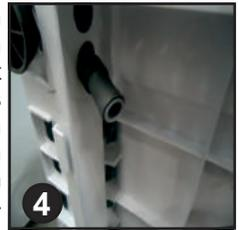
5. Schließen Sie den neuen Ablaufschlauch an die Abwasserleitung an.
